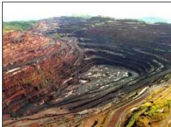
Consultoria em projetos na mina de Carajás Reforço do muro de arrimo.
